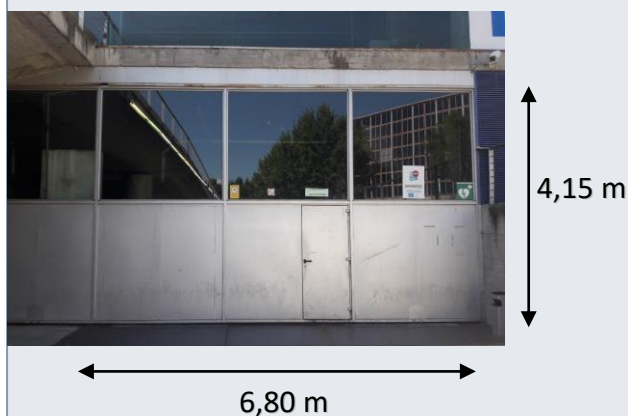
Cota 0, acceso por rampa descendente (anchura útil)
