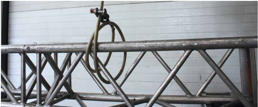
Foto 1: Safety point muy mal colocado.
