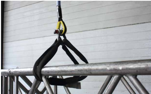
Foto 34: Eslingado que reduce en un 50% la capacidad de carga
