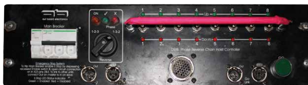
Foto 12: Control de motores 8 canales
